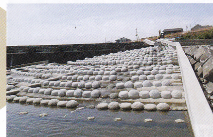
狭山市にある田島屋堰に完成した棚田式の魚道。(2015年5月撮影：鈴木)
