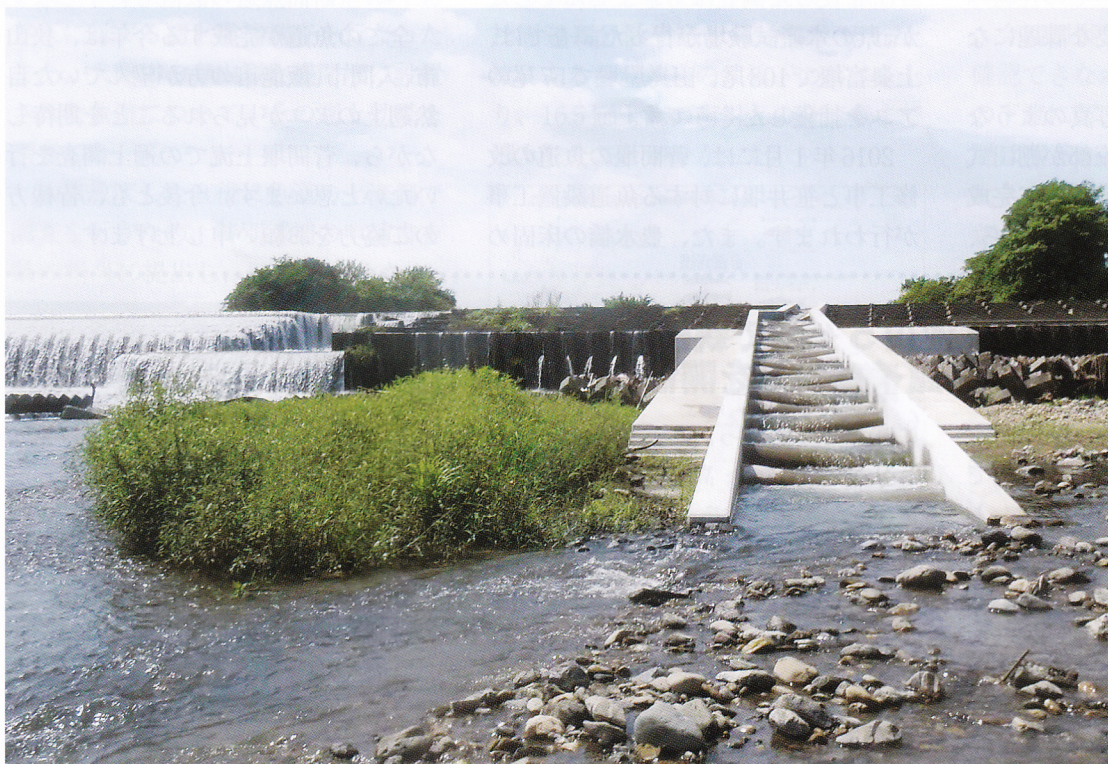
狭山市にある入間川の上奥富堰に完成したユーコーン式の魚道。(2015年8月撮影：鈴木)
